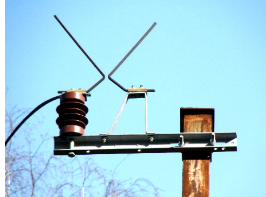
Rys. 2. Nieprawidłowe rozstawienie elektrod wyładowczych w odgromniku różkowym
