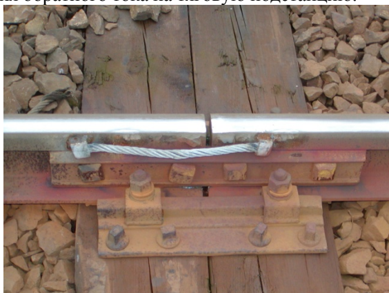
Рис. 1. Продольный стальной рельсовый соединитель приваренный к головке рельса
